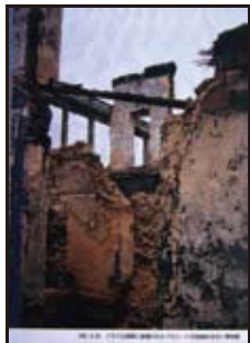
1991.3.24 イラク占領軍に破壊された クウェートの由緒ある古い博物館
